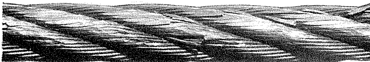
▲ハンマーリングによる素線損傷
